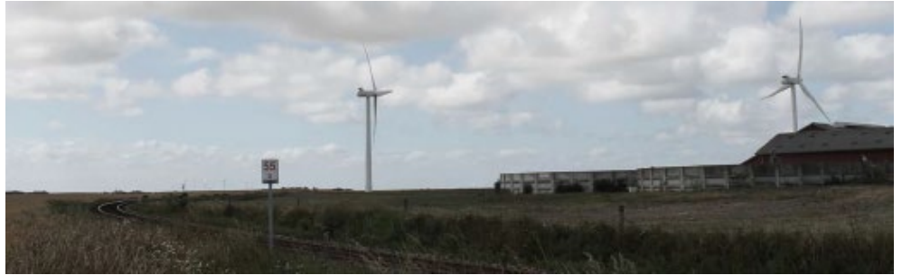
Området er i høj grad præget af tekniske anlæg, - her ses jernbanen, landbrugsbebyggelse og vindmøllerne i tilknytning til lokalplanområdet, set mod syd for Bonnet. Kilde Landskabskarakteranalyse Lemvig Kommune
